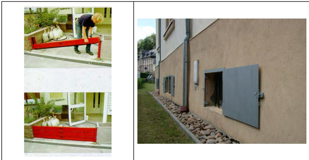
Abbildung 9: Objektschutz mit mobilen Elementen (links) und Beispiel Hochwasserschutz an Fenstern (rechts)
