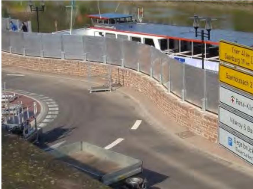
Abbildung 17: Beispiel einer Kombination von Hochwasserschutzmauer mit Dammbalken [Hochwasserschutz.de]
